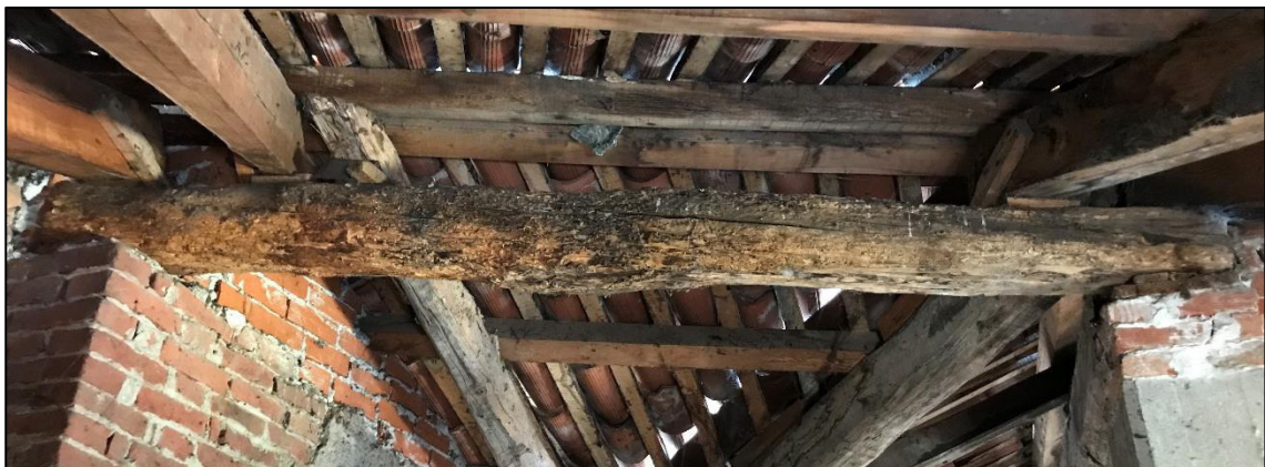
Figura 3 immagine trave in legno da sostituire
